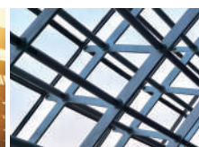
STRUTTURE IN ACCIAIO
