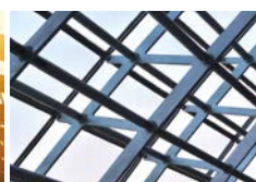
STRUTTURE IN ACCIAIO
