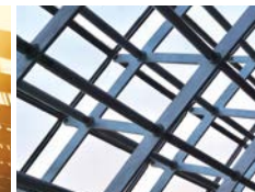
STRUTTURE IN ACCIAIO
