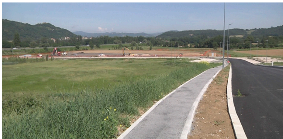
Lavori di urbanizzazione nella parte di zona industriale dove verrà costruito il nuovo stabilimento Salpa
