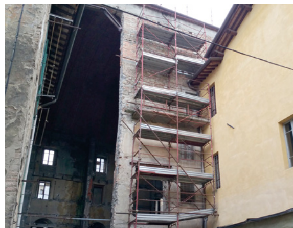
Il cantiere dei lavori
