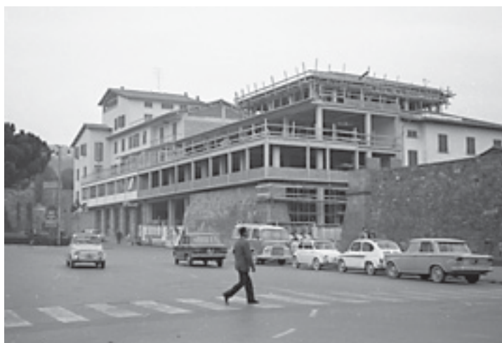
Metà edificio già realizzata e l'altra metà in fase di costruzione
