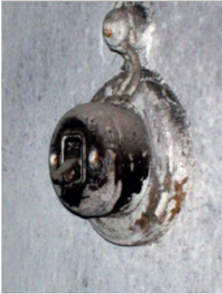
Un vecchio interruttore in ceramica
