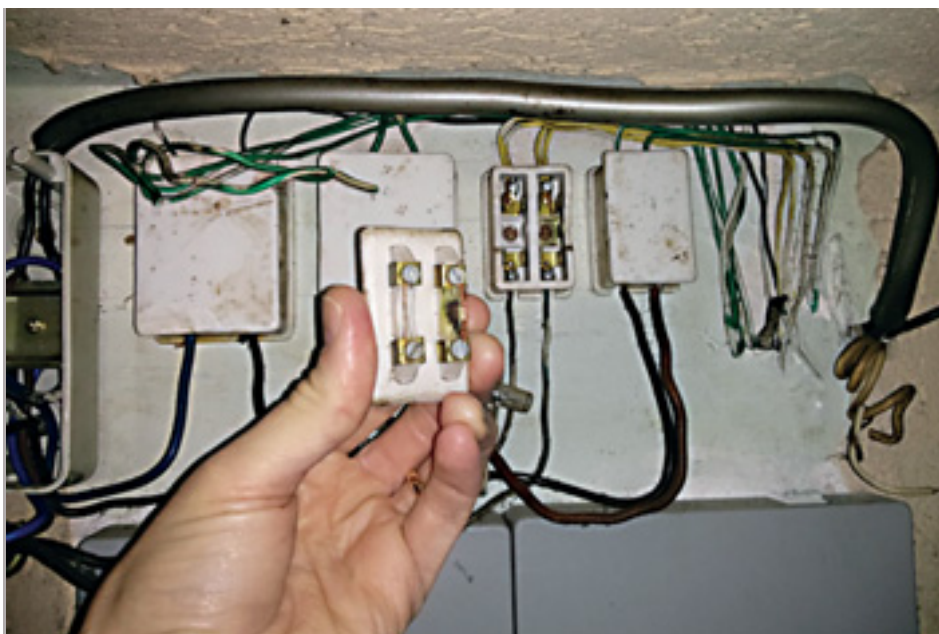
Un fusibile in ceramica
