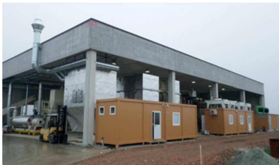
Impianto di gassificazione di legna della Graziella Green Power a Correggio (Re). Si ringrazia per la gentile concessione
