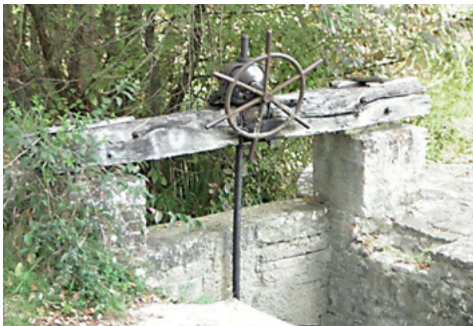
La chiusa del "Cadutone"
