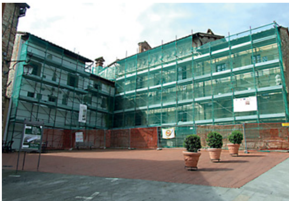
Il cantiere al lavoro nella facciata di palazzo Pretorio ad Anghiari
